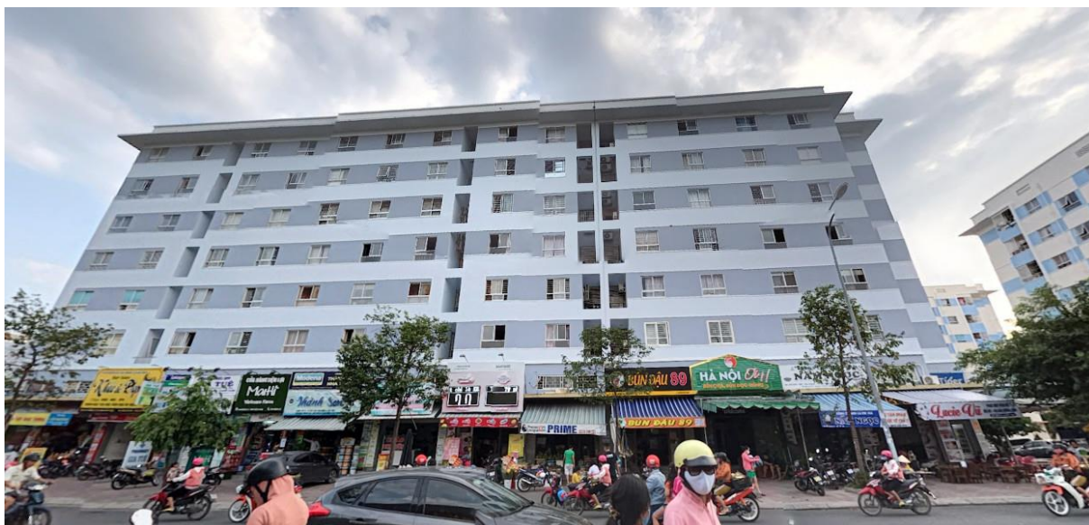
Hình 8. Chung cư CT7 – KĐT Vĩnh Diễm Trung ở Thành phố Nha Trang
