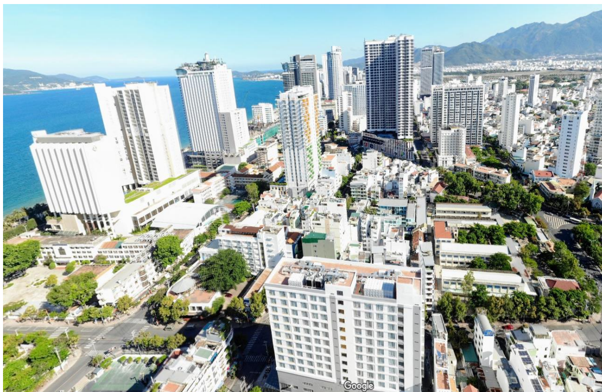
Hình 6. Hiện trạng chung cư ở Thành phố Nha Trang
