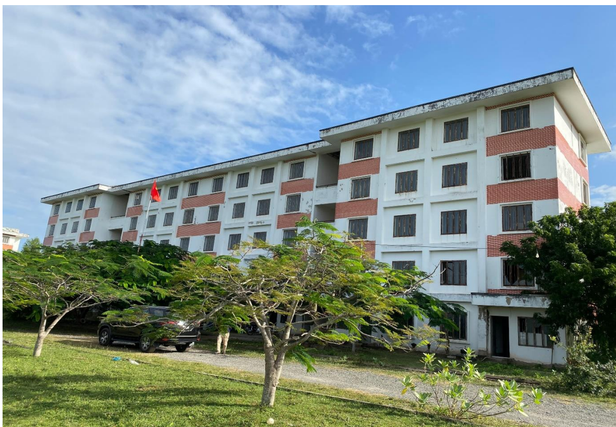
Hình 8. Dự án nhà ở cho công nhân do Công ty TNHH Hoàn Cầu làm chủ đầu tư tại thị xã Ninh Hòa
